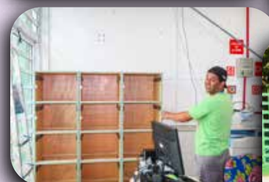
Obras de melhorias no CEI Santa Catarina.
