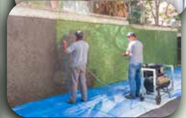
Restauração e pintura externa do muro.
