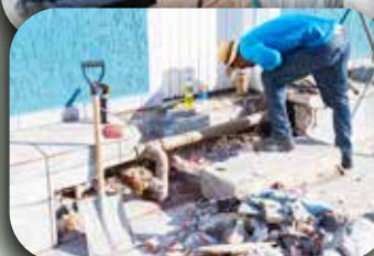
Reparo hidráulico no instituto.
